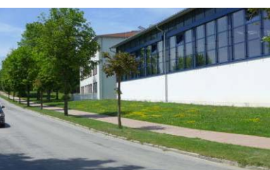
Rückbau zur Parkplatzzufahrt
