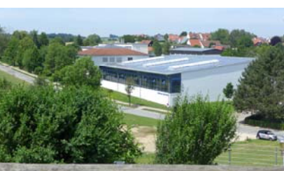
Bestand: Die südliche Ortskante an der Grund- und Hauptschule
